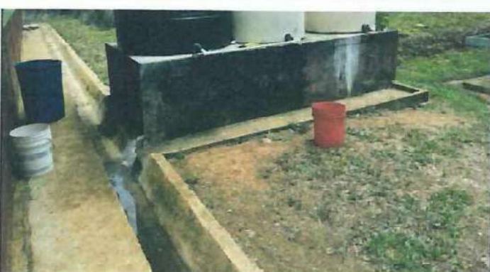
Foto 4: SUSTITUCION DE LOZA DE CONCRETO, AMPLIACION DE PISO DE CONCRETO, PARA QUE YA NO HAYA LODO PARA PODER USARLO.
