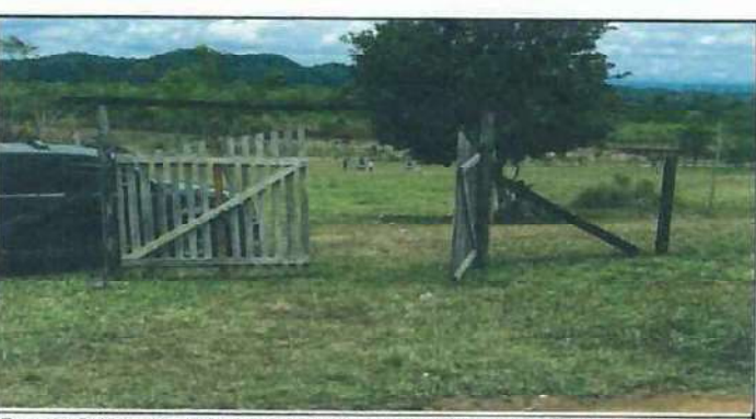
Foto 6: SUSTITUCION DE PORTON DE MADERA POR METAL Y TECHO
